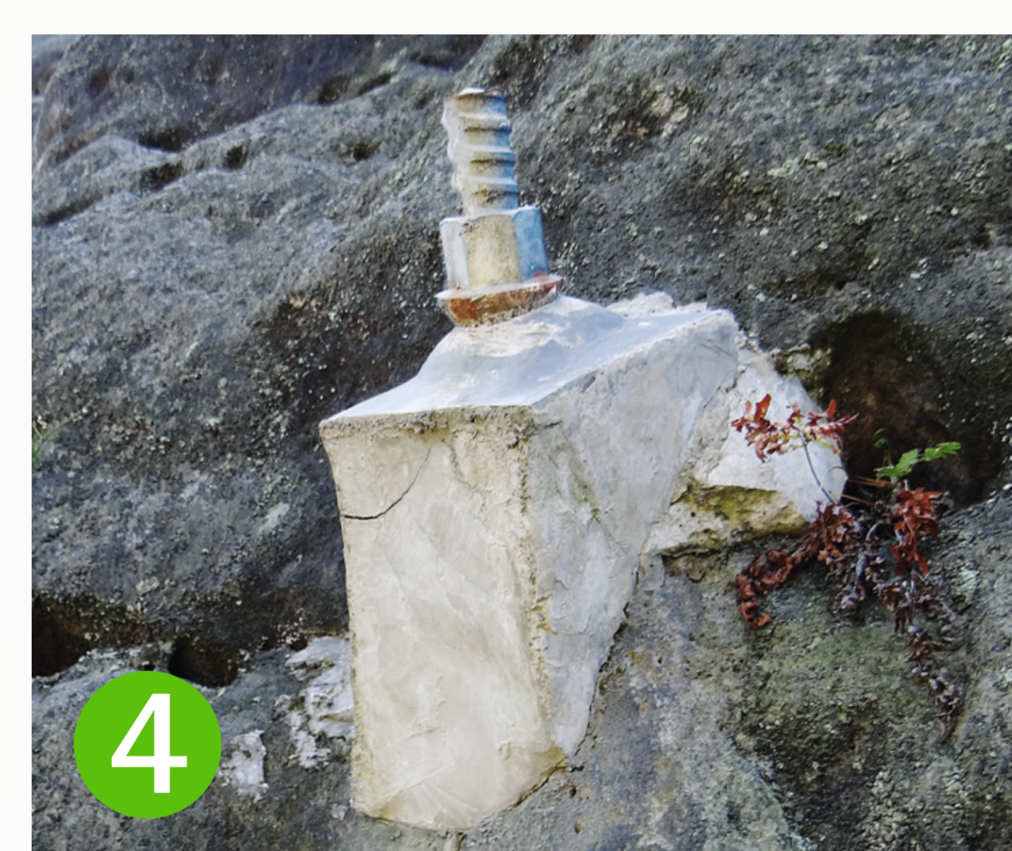
4 Einzelblocksicherung mit Felsnagel/Anker
