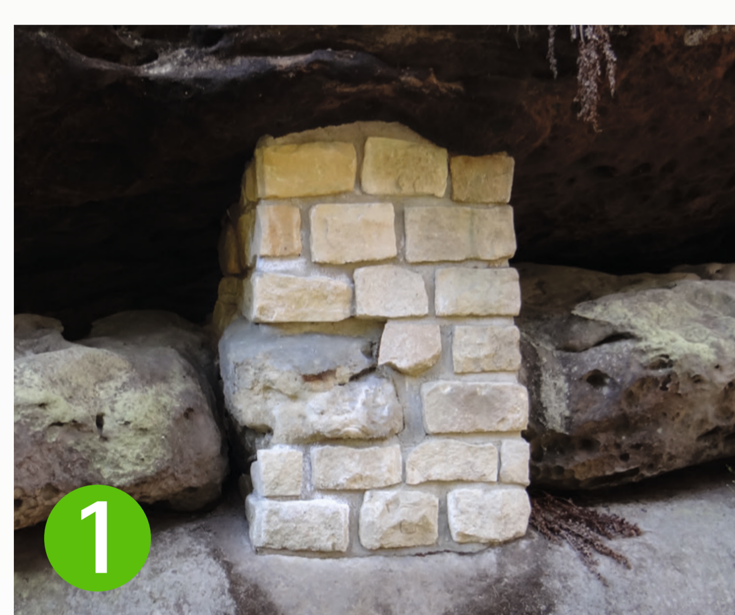
1 Untermuerung durch Stützpfiler/Knagge
